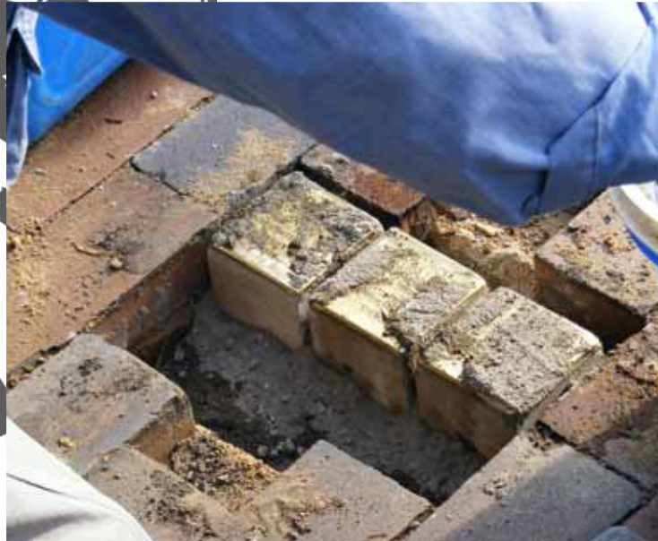
Die Stolpersteine werden in einem Betonbett verlegt.
