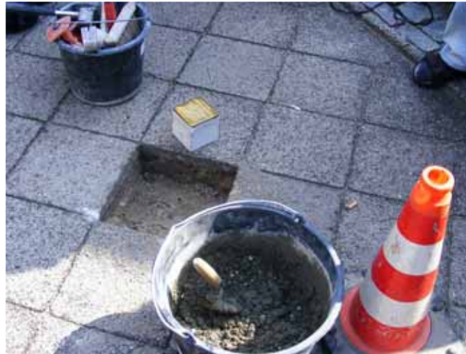
Ein Loch im Pflaster - die Verlegung wird vorbereitet.
